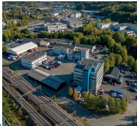
1) Alna Park (Strømsveien 221-223 og Breivollveien 13), 12 900 kvm
