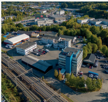
1) Alna Park (Strømsveien 221-223 og Breivollveien 13), 12 900 kvm
