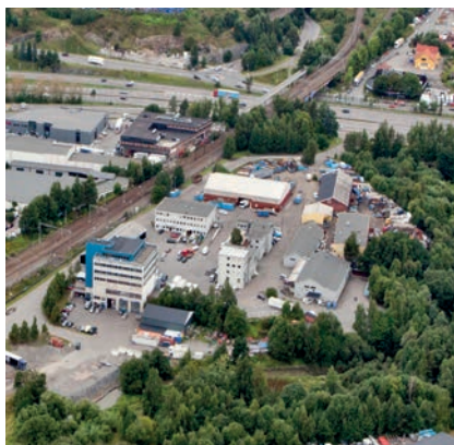
1) Alna Park (Strømsveien 221-223 og Breivollveien 13), 12 900 kvm
