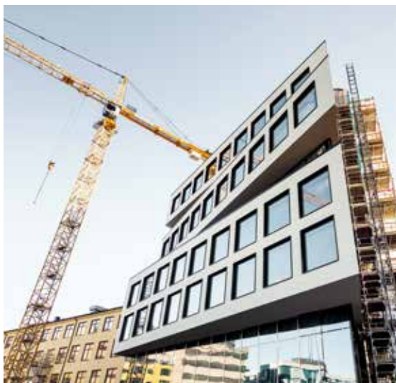
Fabrikken under utbygging/rehabilitering mot illustrasjonen vist til høyre
